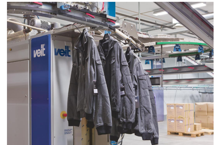
Automatische Beladung des Tunnelfinishers.
